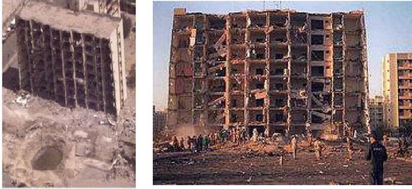
برج الخبر وقد حطمت الواجهة بالكامل والحفرة التي نتجت عن انفجار الصهرنج
